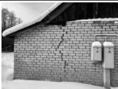
Mājas ārsiena un elektrības pieslēgums
